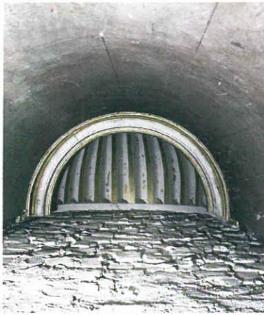
L'absidiola destra vista dall'interno prima dell'inizio dei lavori. Adibita per oltre un secolo a ripostiglio essa mostrava la parete concava in marmorino rosso e il catinetto dipinto a conchiglia.
