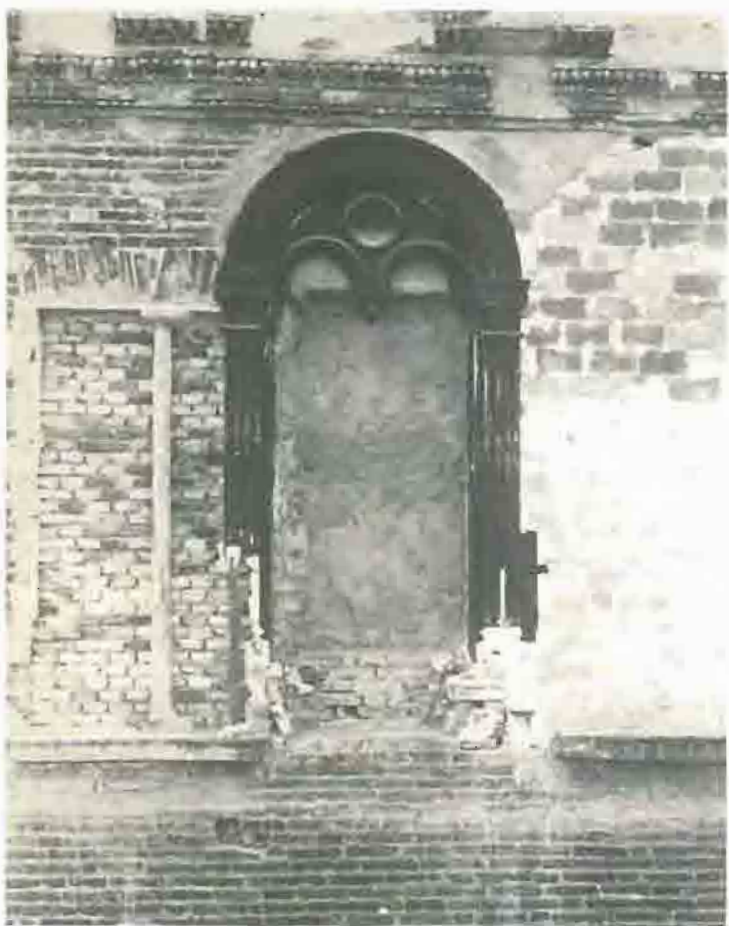
Sulla base degli elementi rinvenuti durante il restauro degli anni '20 sono stati realizzati modelli in gesso che le foto mostrano in opera sulla campitura di fucciata (vedi documentazione in appendice).
