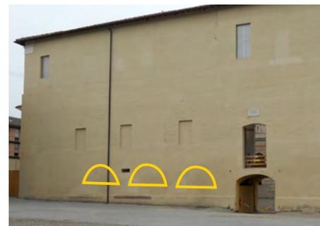
Le finestre semicirculari sul prospetto est che segnano l'unghia delle volte a crociera, sono l'unica traccia dell'iniziale struttura. La loro riapertura ripropone la situazione originaria e consente la razionale illuminazione del piano ipogeo.
